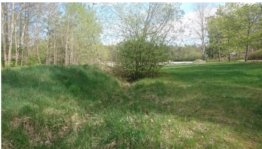
Figur 9. Öppet mindre dike genom kv.7G. Foto: WRS AB.
