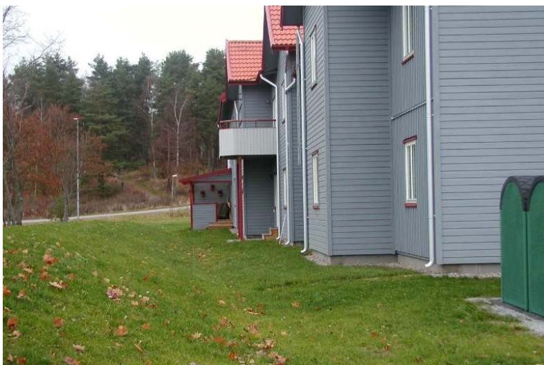
Figur 17. Notera att marken sluttar bort från huset. Där gräsmattan möter den högre terrängen finns ett lågområde/svackdike som kan avleda stora vattenmängder vid extrem nederbörd och där vattnet även tillåts "stå" och infiltrera under längre tid. Foto: WRS AB.
