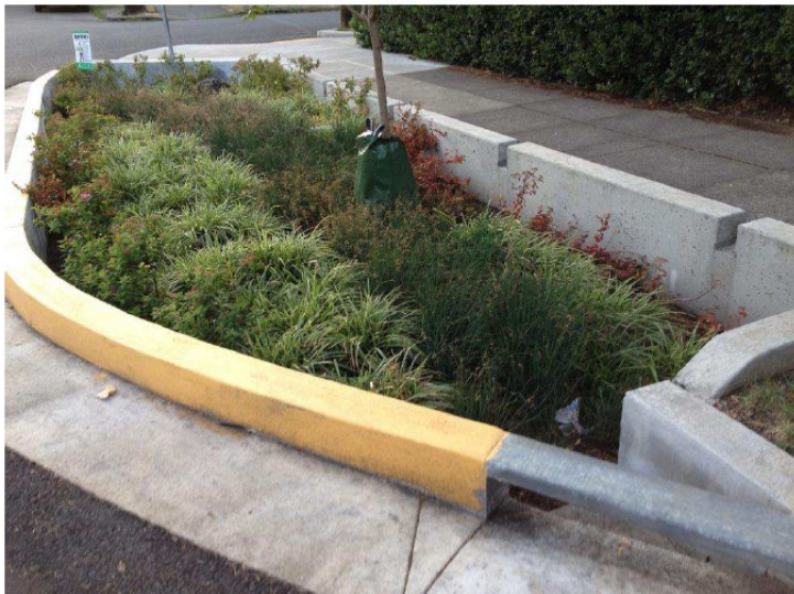
Figur 20. Bildexempel från Portland på nedsänkt växtbädd med träd och andra växter dit dagvatten från väg och trottoar leds. Foto: WRS AB.
