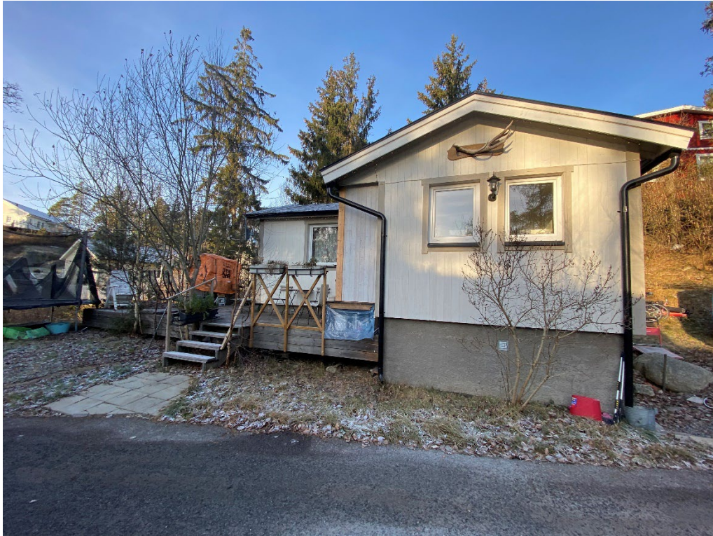
Bild som visar befintlig komplementbyggnad som ligger norr om befintlig in-och utfart mot Vidablicksvägen.
