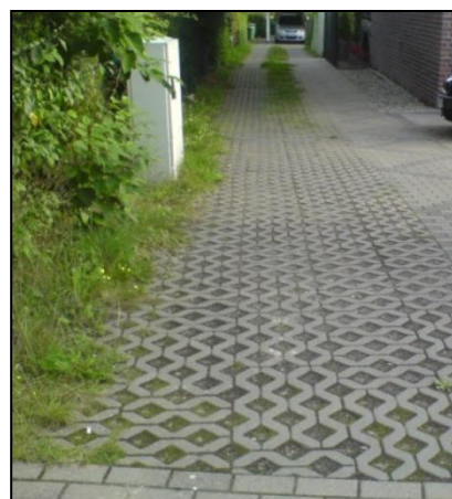
Figur 8-4. Exempel på genomsläpplig beläggning i form av gräsarmerad betongbeläggning (Stockholms Vatten och Avfall, 2017).
