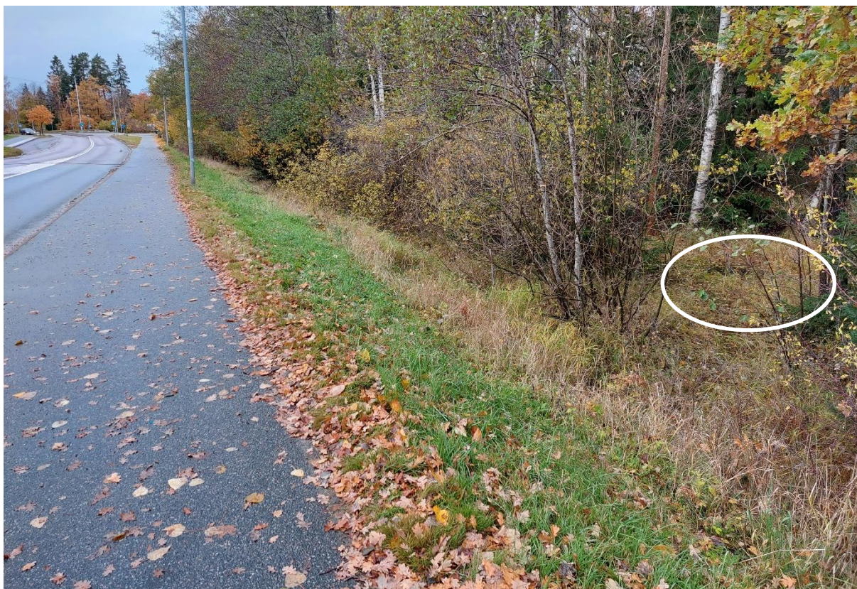
Figur 3–5. Tyresövägen och planområdet i bild. Stående vattenansamling markerad med vit cirkel.
