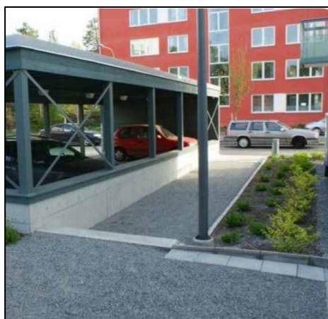
Figur 8-3. Exempel på genomsläpplig beläggning i form av grus (Uppsala Vatten, 2014).
