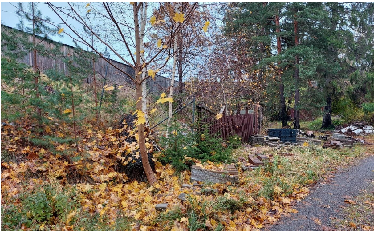
Figur 3-2. Vall mot grustag syns bakom träden. Längs med foten av vallen skapas ett dike.
