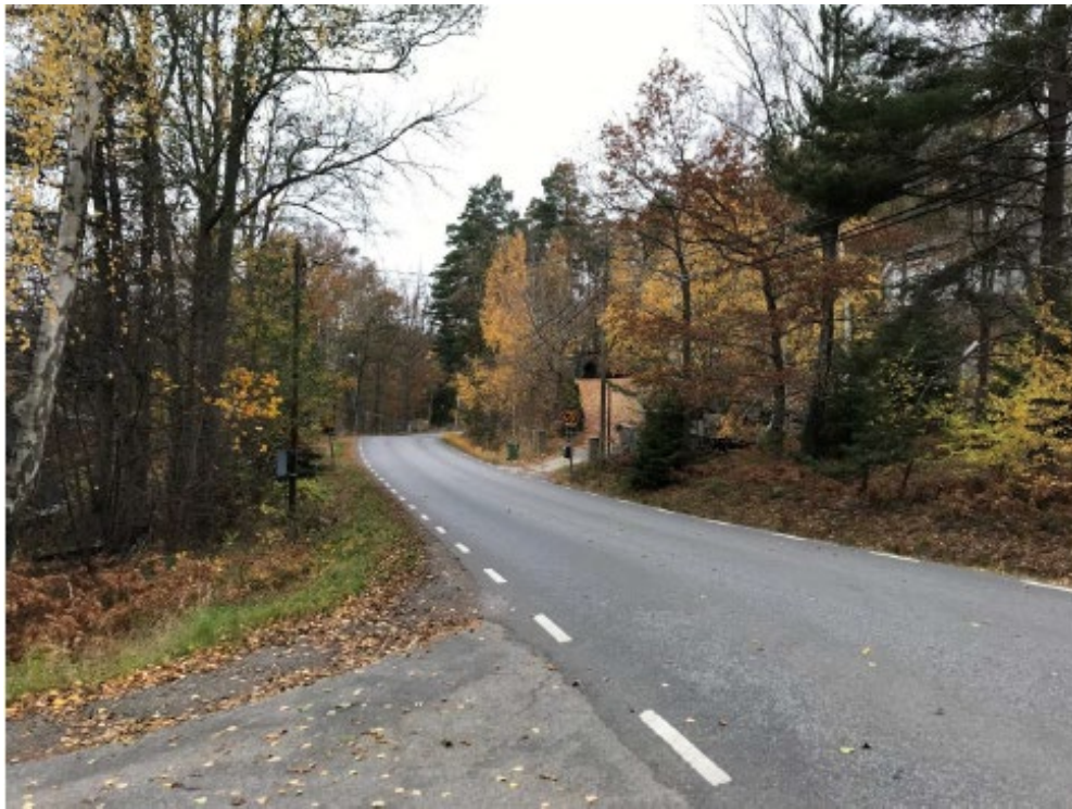
Bild över Breviksvägen vid anslutningen till Fasanvägen, vy västerut (Sweco 2020-09-30)
