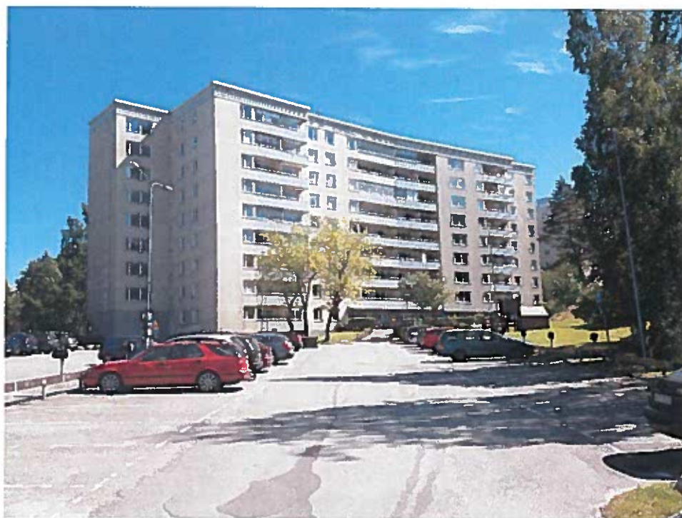
Befintlig markparkering med Brf Gösen 3 i bakgrunden.
