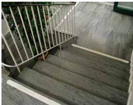
Kontrastmarkerade trappsteg i C3L:s huvudtrappa.
