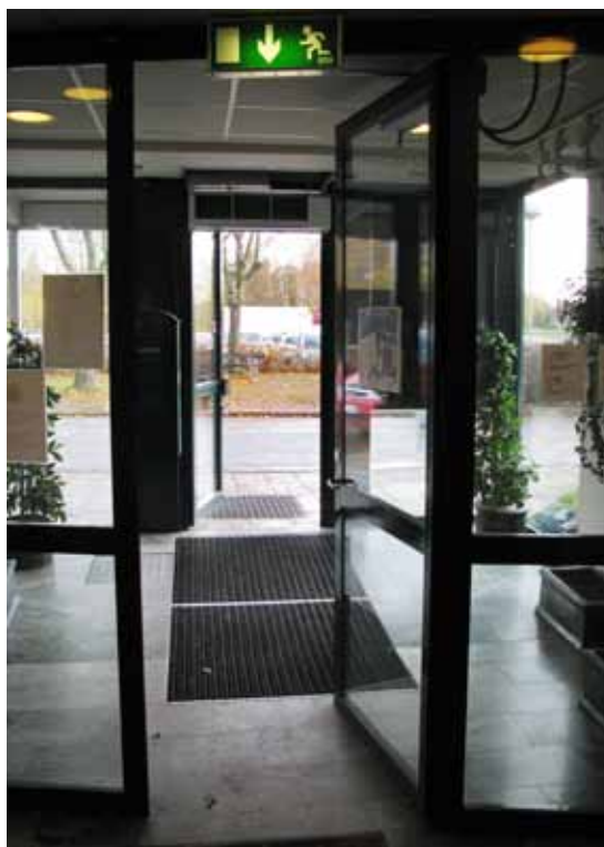
Entrédörr till C3L efter installation av automatisk dörröppnare.
