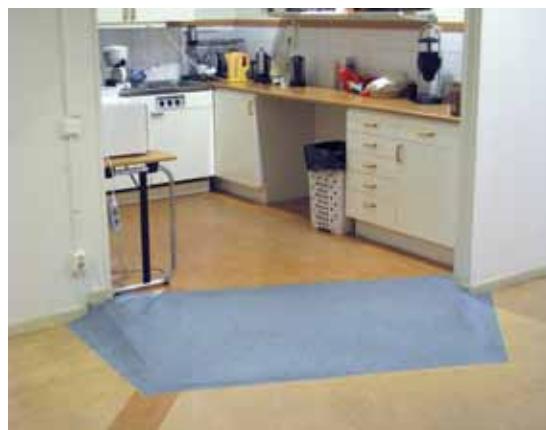
Eleventry med förhöjt golv i C3L, före och efter åtgärd.
