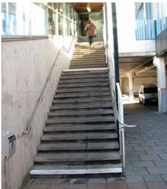
Utvändig kontrastmarkerad trappa.
